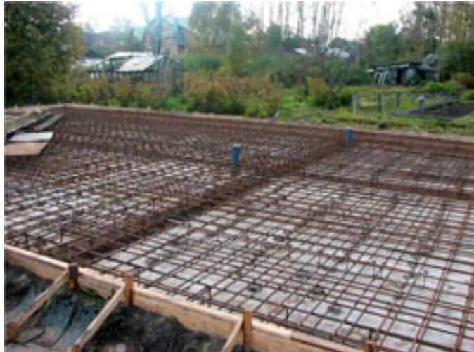
Различают два вида сплошных фундаментов: из плит и из перекрестных лент. Их возводят из монолитного железобетона, чтобы придать фундаменту пространственной жесткости.
