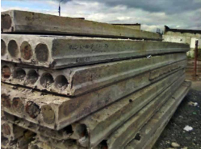
Перекрытия – это конструктивные элементы здания, которые делят здание на этажи, служат для распределения нагрузки от собственной массы и массы находящихся на них предметов и передачи этой нагрузки на несущие конструкции – стены, опоры. Также перекрытия придают дополнительную пространственную жесткость всему строению, так как связывают между собой отдельные стены.
